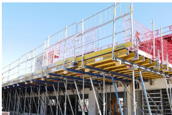
14 Tables Dokamatic ont été utilisées pour coffrer des portes à faux du bâtiment allant jusqu'à 3.5 m Crédit photo : Doka France.
