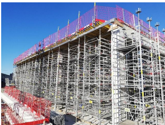
Plus de 900 m 2 de Tour Excellence ont été déployées sur ce chantier, sur des configurations allant de 2.60 m à 7.90 m. Crédit photo : Doka France.
