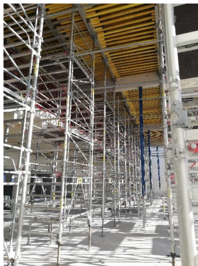
Un platelage a été réalisé grâce à la Tour Excellence qui a pu reprendre les charges importantes. Crédit photo : Doka France.
